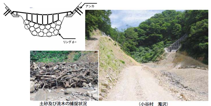
流木対策の事例（左：鋼製牛柵（新燃岳）、右：ワイヤネット）
