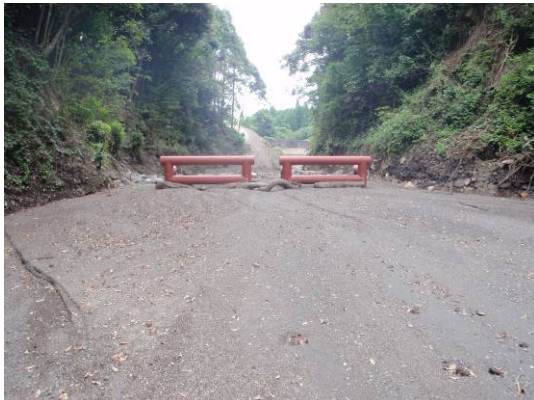
流木対策の事例（左：鋼製牛柵（新燃岳）、右：ワイヤネット）
