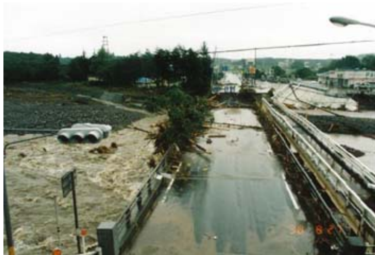
図 5.5 平成10年の余笹川の水害（国道4号付近の状況）
