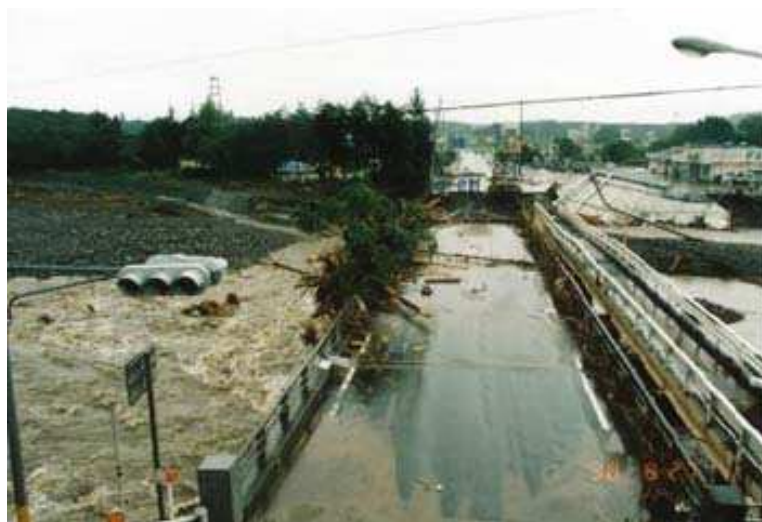
図 5-6 平成 10 年の余笹川の水害（国道 4 号付近の状況）
