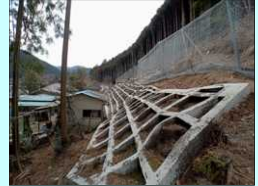
防護柵・のり枠の整備を行って安全に
