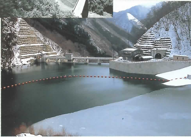
試験湛水でサーチャージ水位に達しているダム
