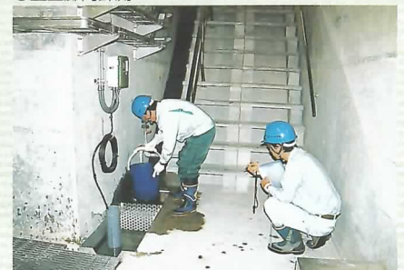
●監査廊内計測
