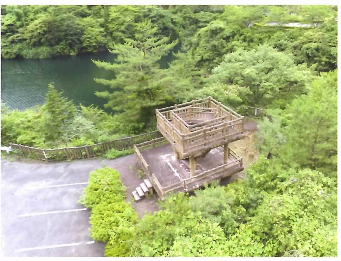
▲ 左岸上流展望台
