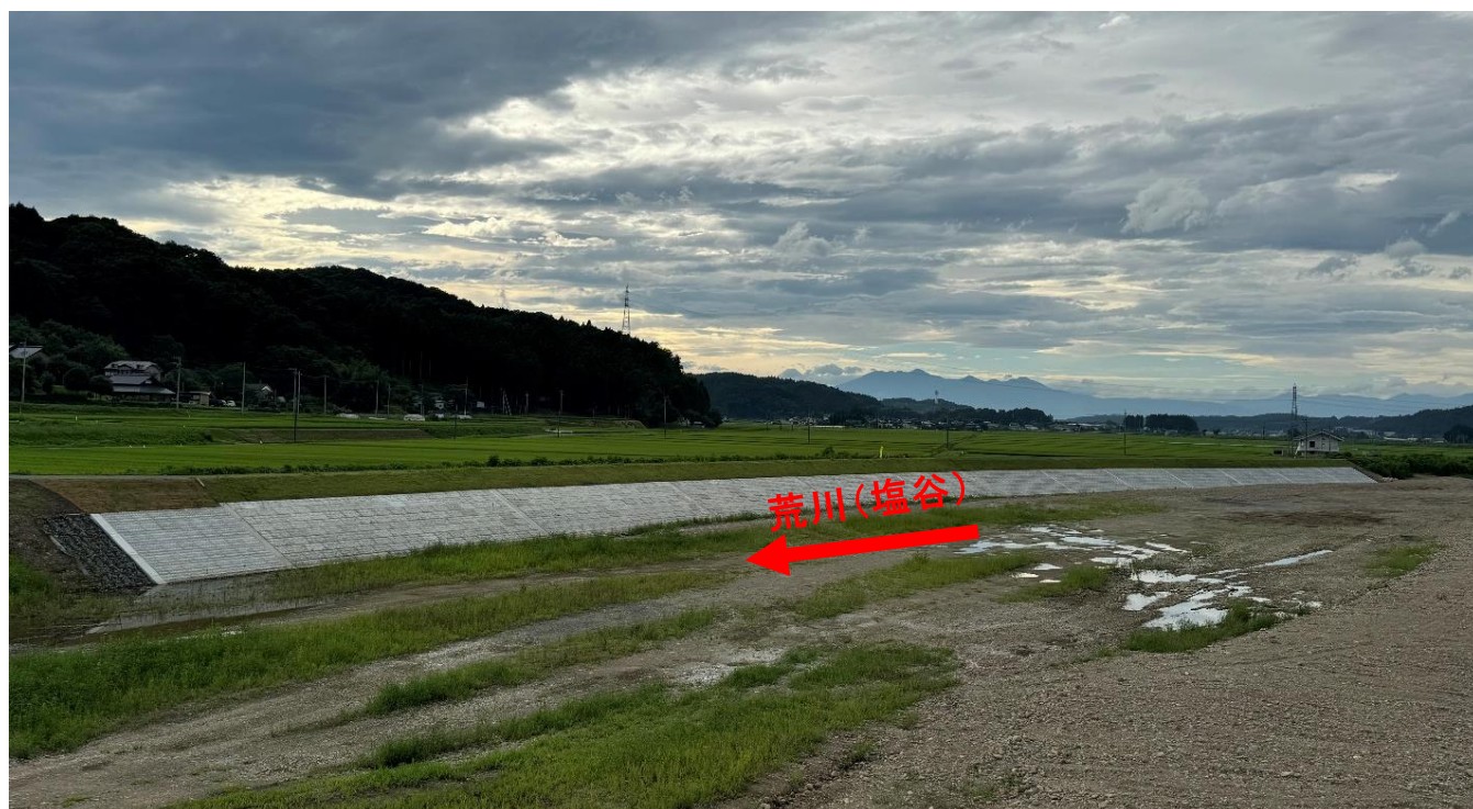
【復旧完了状況】
