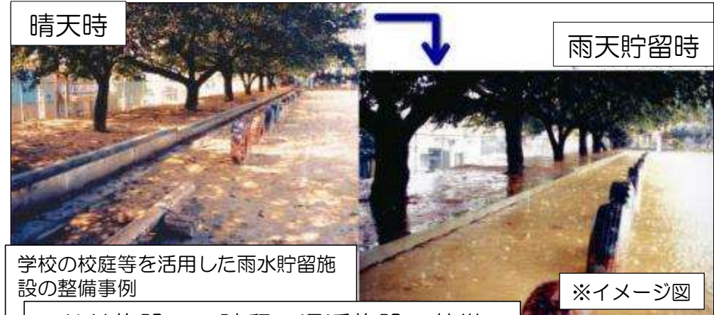
公共施設への貯留・浸透施設の整備
