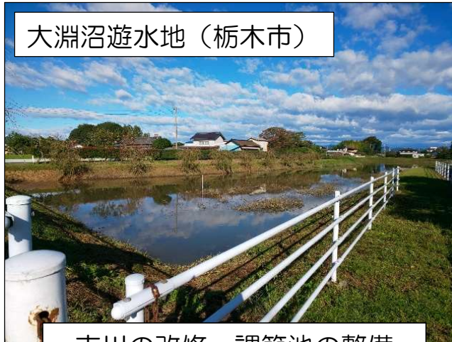
支川の改修、調節池の整備
