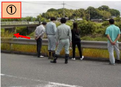
①真岡土木の点検状況(5/23) 一級河川五行川(真岡市大和田)
