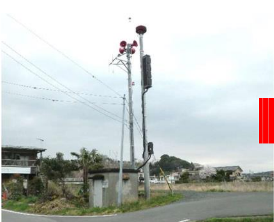
西荒川ダム 喜連川放流警報設備(さくら市喜連川)
