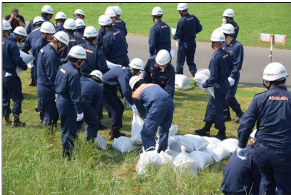
【積土のう工法】
