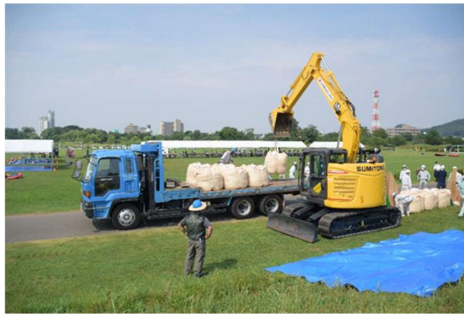
【大型土のう設置訓練】
