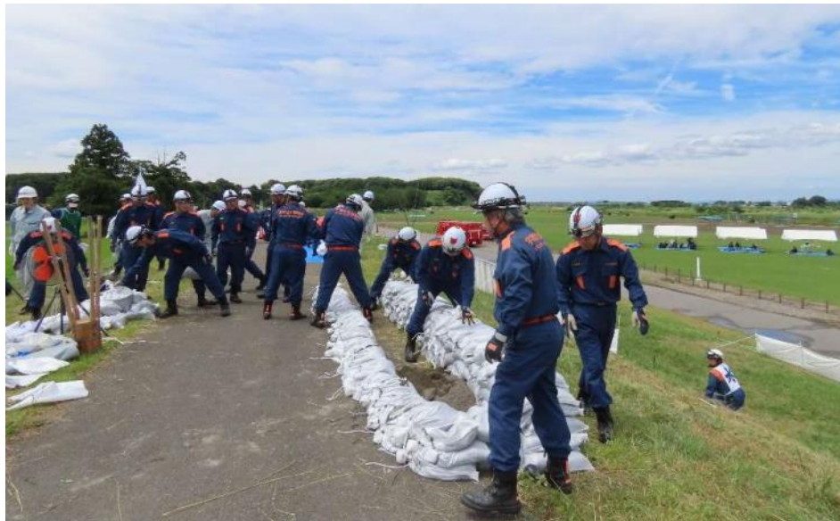
【積土のう工法】
