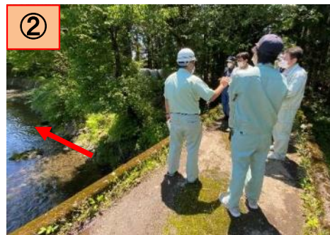
⑥日光土木の点検状況(5/24) 一級河川古大谷川(日光市川室)
