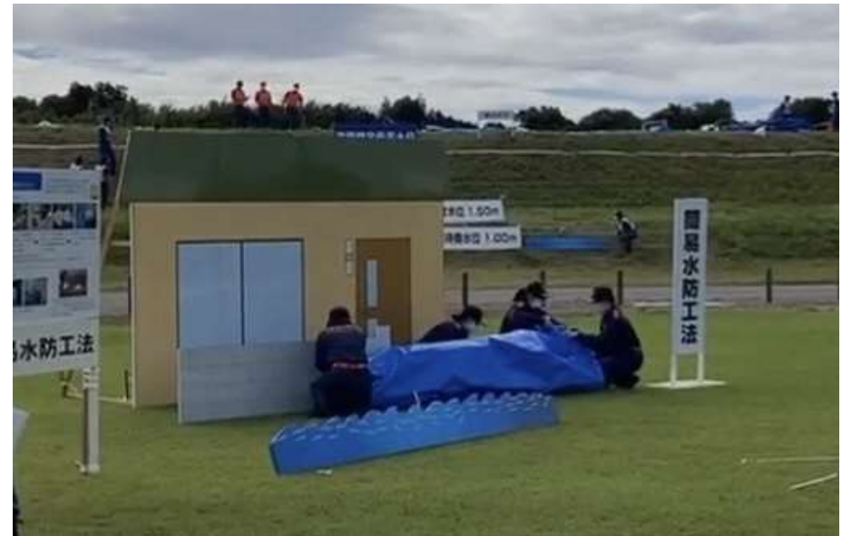
【簡易水防工法（住宅への侵入防止）】
