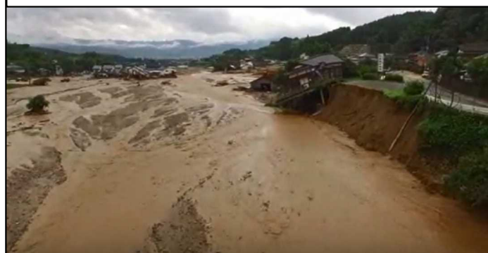
赤谷川の被害状況 (7月7日国土地理院撮影)
