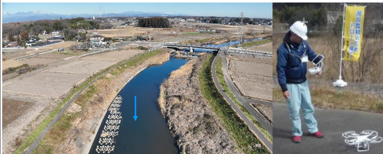
UAVを活用した目視点検
