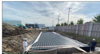
県立足利高校新校整備(施工事例)
