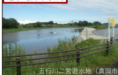
遊水地貯水状況
