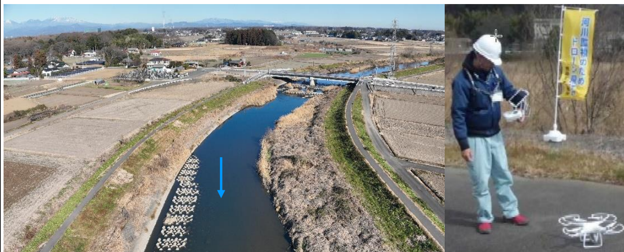
UAVを活用した目視点検
