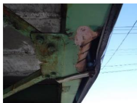
■主桁：変形・欠損(健全性Ⅱ)
