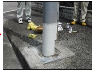
端部補強シートの設置状況
