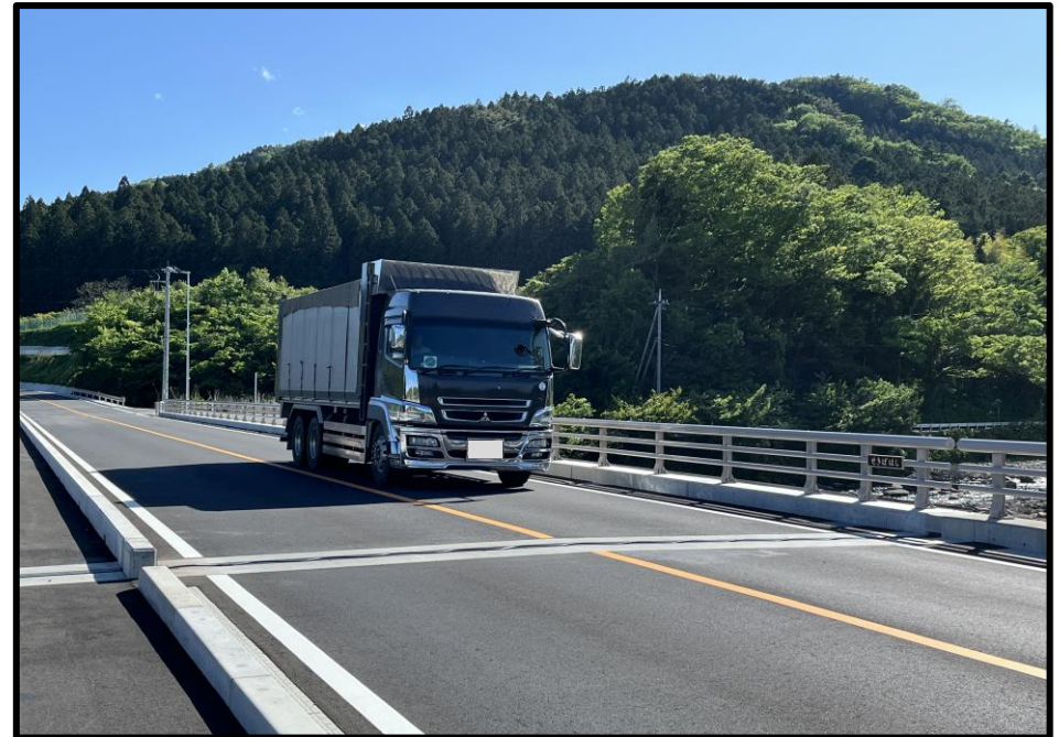
堰場橋から南(金沢方面)を望む
