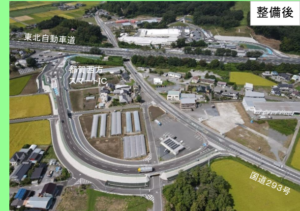
国道293号 都賀西方（栃木市）
