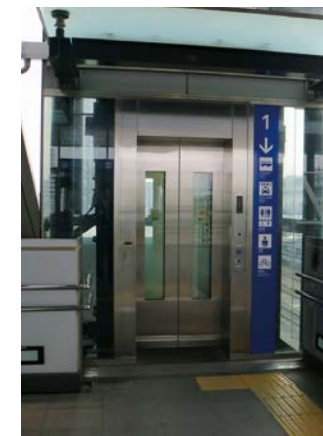
●駅のエレベーター
