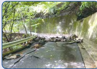
主要地方道塩原矢板線 那須塩原市塩原 (R2.9)
