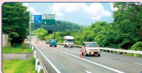
アクセス道路の整備(国道120号/日光市)
