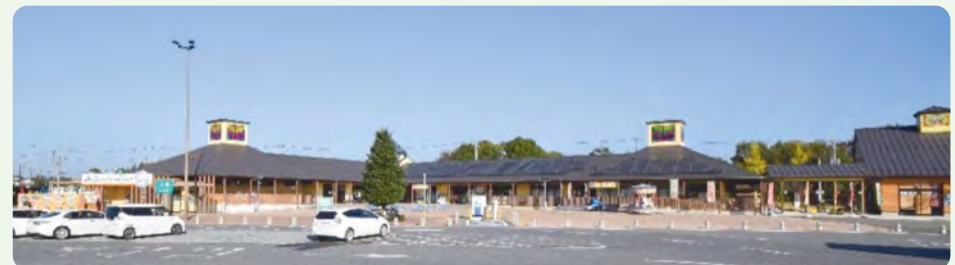
道の駅みぶ(防災道の駅 令和3年6月選定)
