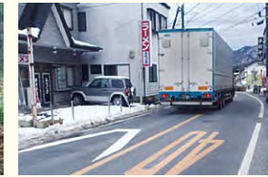
川治温泉の道路状況
