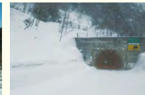
冬期閉鎖前の金精トンネル
