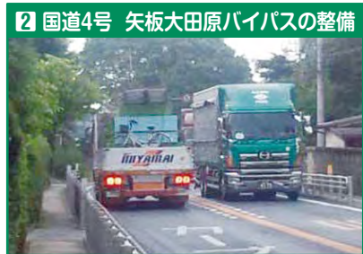
沿道に住宅が立ち並び混雑する国道4号 (大田原市 上石上付近)
