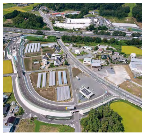
都賀西方スマートIC (2023.9 供用開始)
