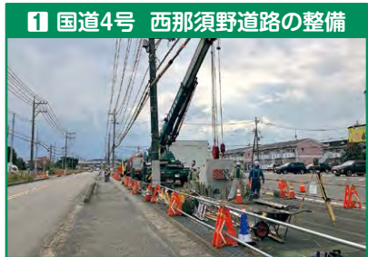
那須塩原市西富山地区の施工状況
