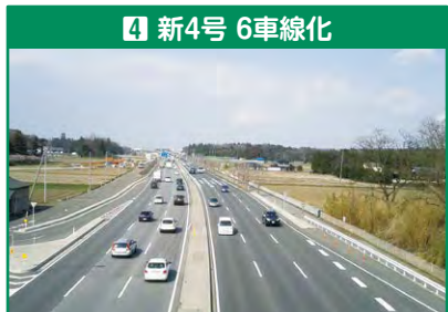
平成25年4月に県内の新4号全区間が6車線化完了
