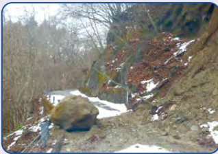
一般県道黒部西川線 日光市土呂部 (R2.4)
