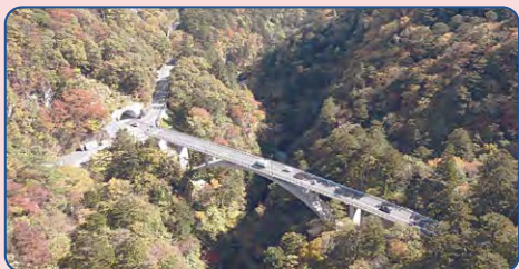
アクセス道路の整備(国道400号/那須塩原市)
