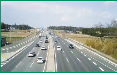
平成25年4月に県内の新4号全区間が6車線化完了
