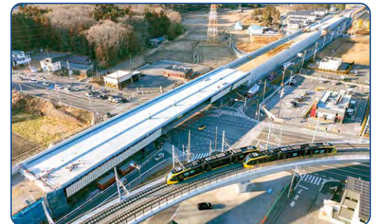
宇都宮高根沢バイパス野高谷立体(仮称)整備状況 2023.9
