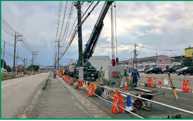
那須塩原市西富山地区の施工状況
