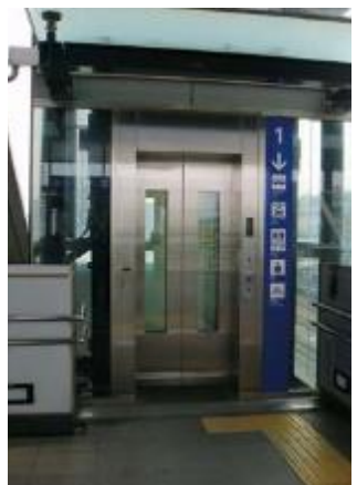
●駅のエレベーター
