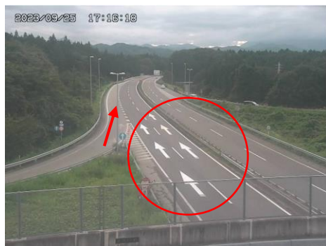
逆走防止対策の例①(路面表示)
