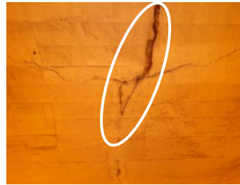
トンネル老朽化対策(鳴虫山トンネル)
