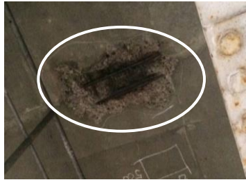
橋梁老朽化対策例①(銭沢橋)
