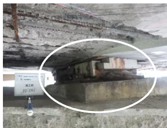
橋梁老朽化対策例②(日光IC橋)
