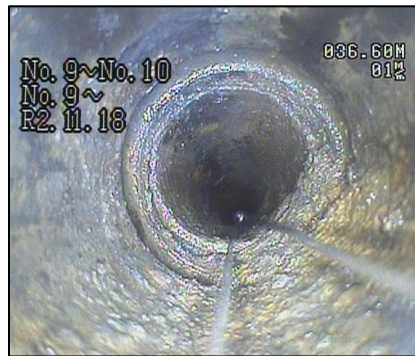
管内部が変形、通信線が切断
