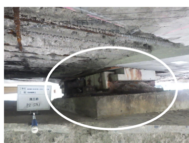
橋梁老朽化対策例②(日光IC橋)
