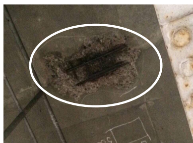
橋梁老朽化対策例①(銭沢橋)
