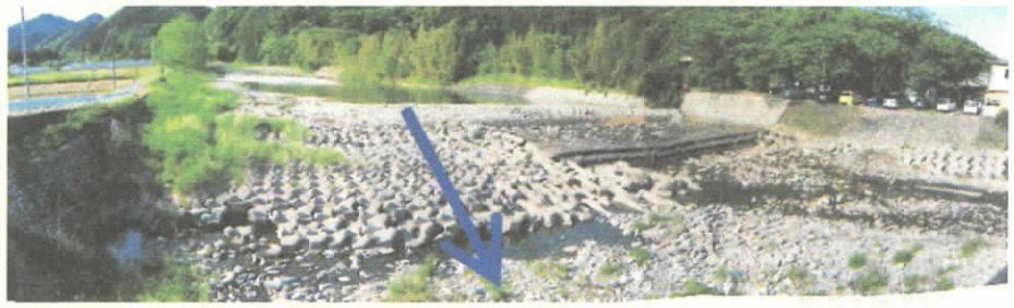
②改修前 大関橋上流付近
