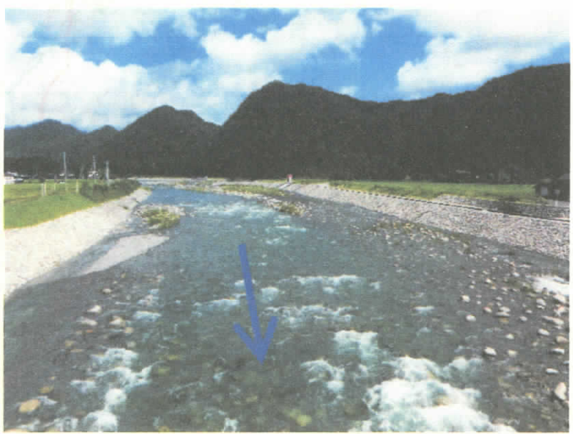
③改修後 大関橋上流付近
