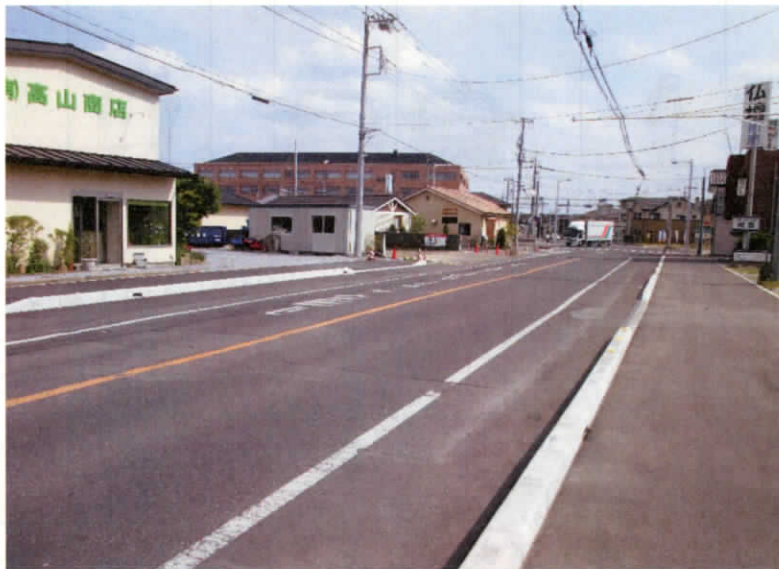
写真③ 整備後の状況(樋ノ口河合線交差点周辺)
