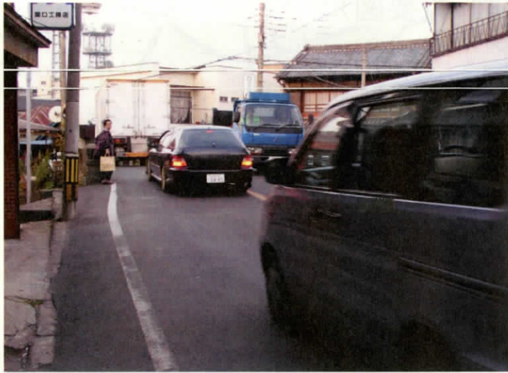
写真① 歩道のない現道での歩行者と車両の錯綜状況(開明橋周辺)
