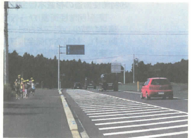
板橋バイパス
