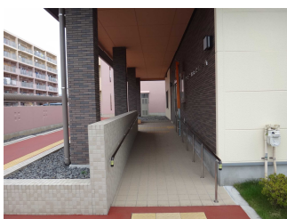
【集会所 外部スロープ】
