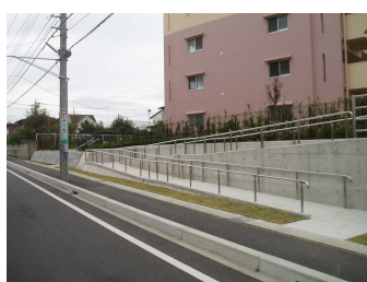
【団地東側 スロープ】
