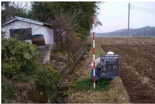
農業用排水路整備前（第2農場地区）
