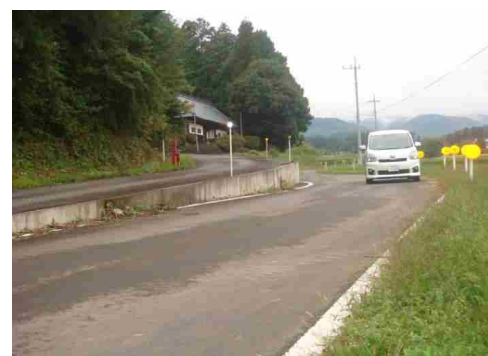
集落道路整備後（平野地区）
