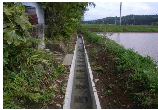
農業用排水路整備後（第2農場地区）
