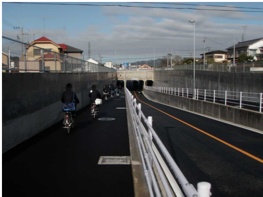
整備後（黒袴迫間線若松アンダー）
