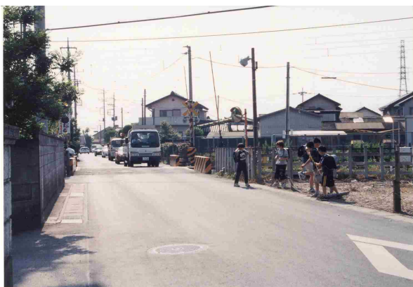
整備前（市道堀米 64 号線）
