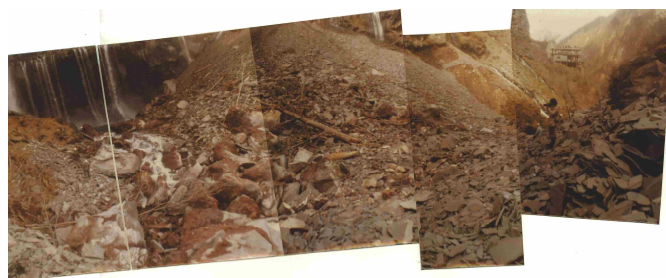
S51 斜面崩落後の「華巖の滝」壺付近における崩落状況
