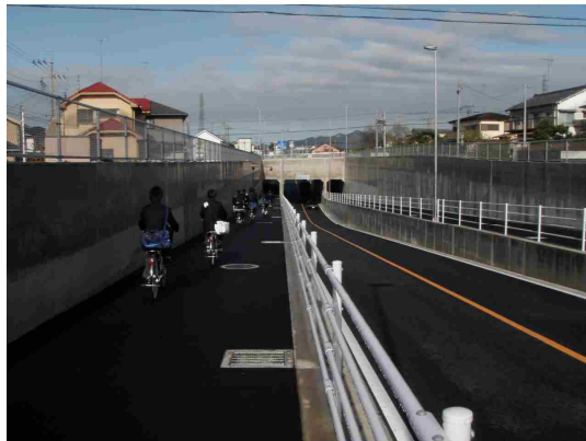
整備後（黒袴迫間線若松アンダー）
