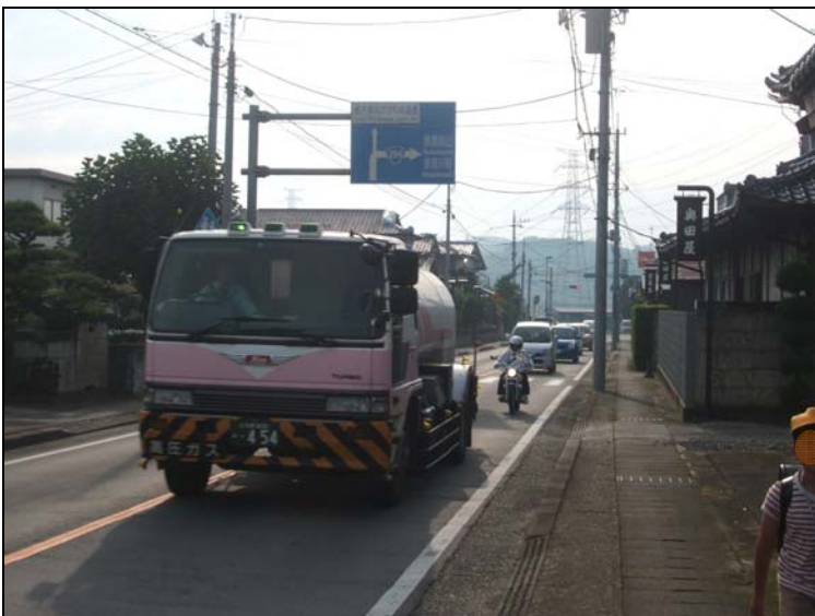
写真 3 : 歩道整備の状況 : 幅員 W=1.5m
