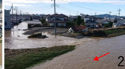
堤防決壊状況 (令和元年10月13日)
