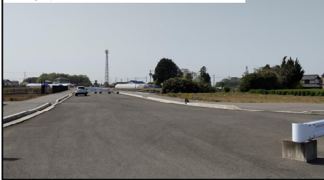
工事実施済み区間の状況
