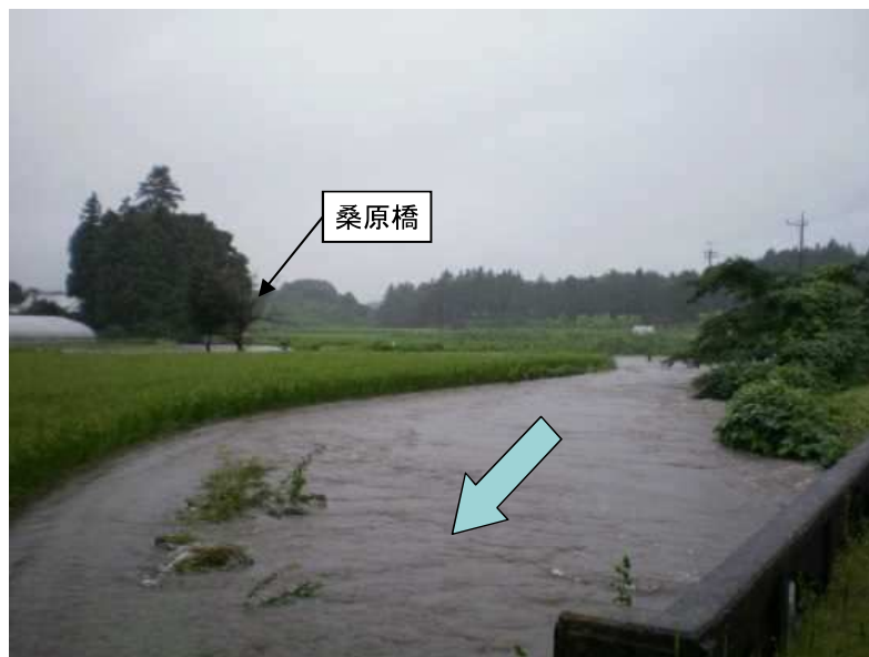
①出水状況 日光宇都宮道路 上流
