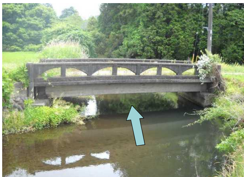
②整備前 桑原橋上流
