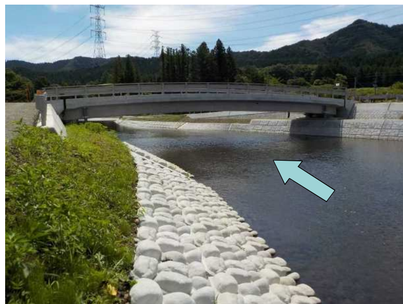
③整備後 桑原橋上流
