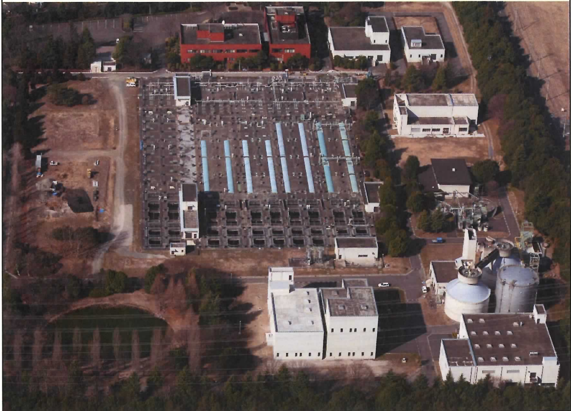
上から見た県央浄化センター（平成 24 年 2 月撮影）
