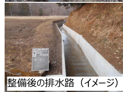
排水路の状況
