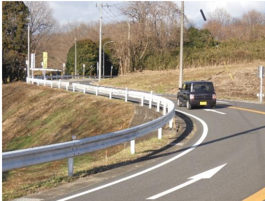
□整備前(旧道)(急カーブ・急こう配)
