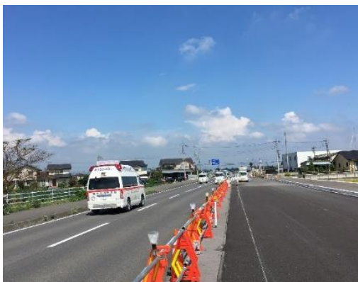
①救急車両のBP走行状況
