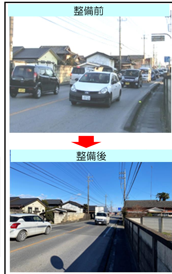
① 橋本北交差点の状況
