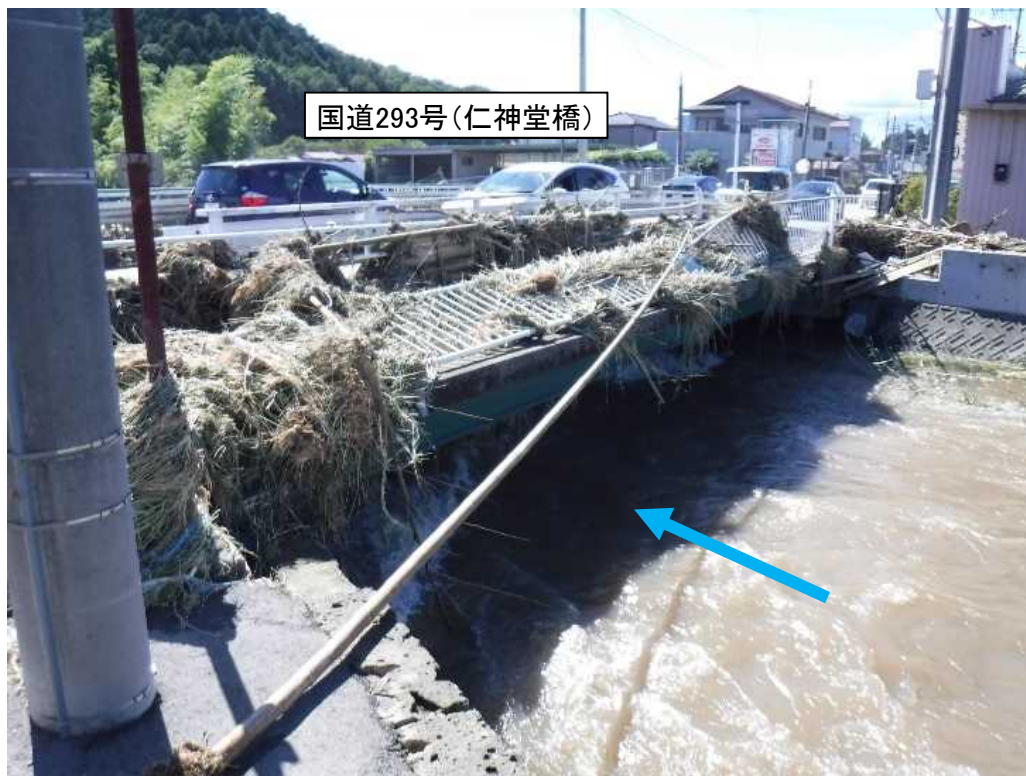
③令和元年10月出水（9.4k 仁神堂橋 鹿沼市仁神堂）
