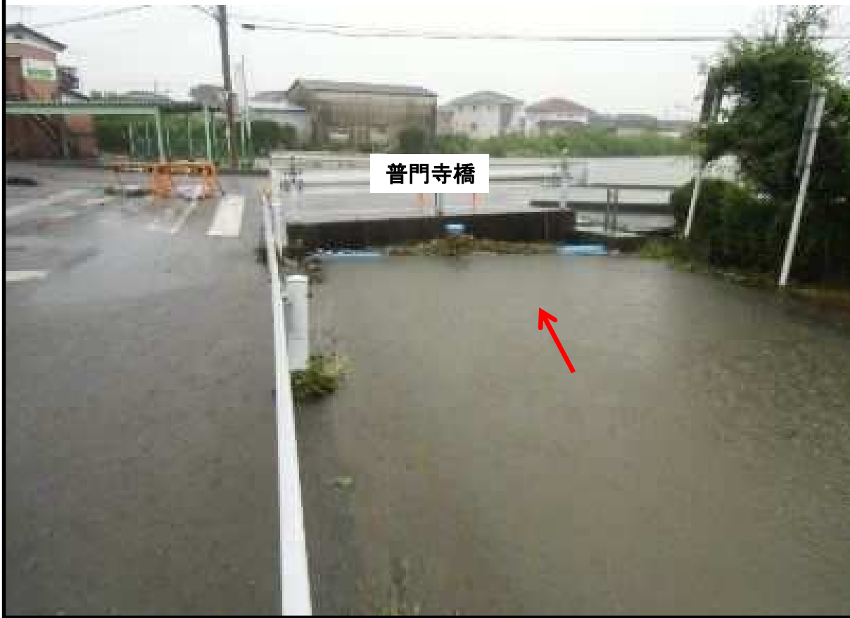
① 河道断面が狭小であるため溢水している
