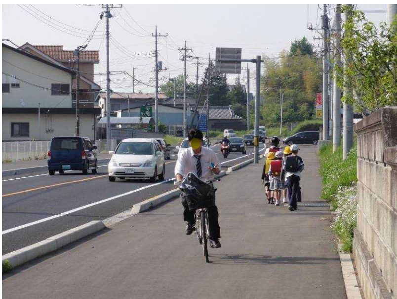
写真 3 : 現道拡幅部の供用状況
