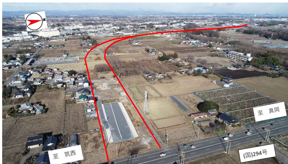
写真1：起点側（国道294号取付部）
