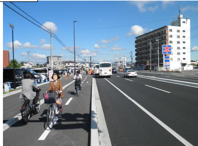
整備後の供用状況
