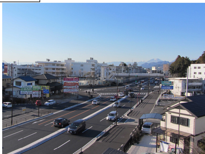
整備後の供用状況
