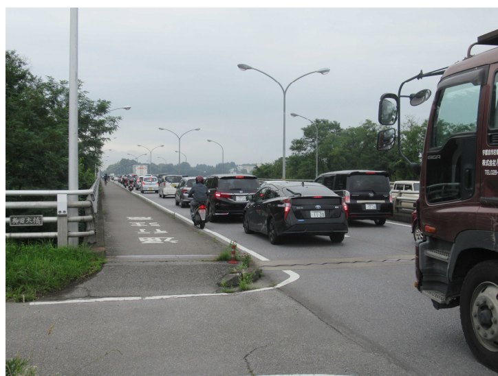
写真 2 : 現道の状況 (柳田大橋)
