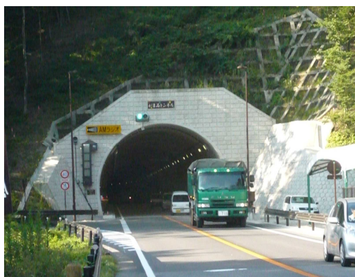
写真 3 : 供用済区間 (第 1 トンネル)
