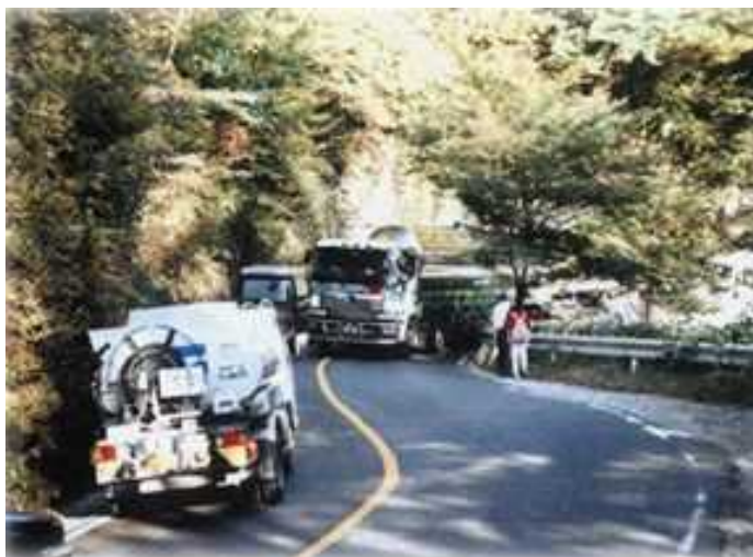
写真 1 : 現道の状況 (すれ違い困難状況)
