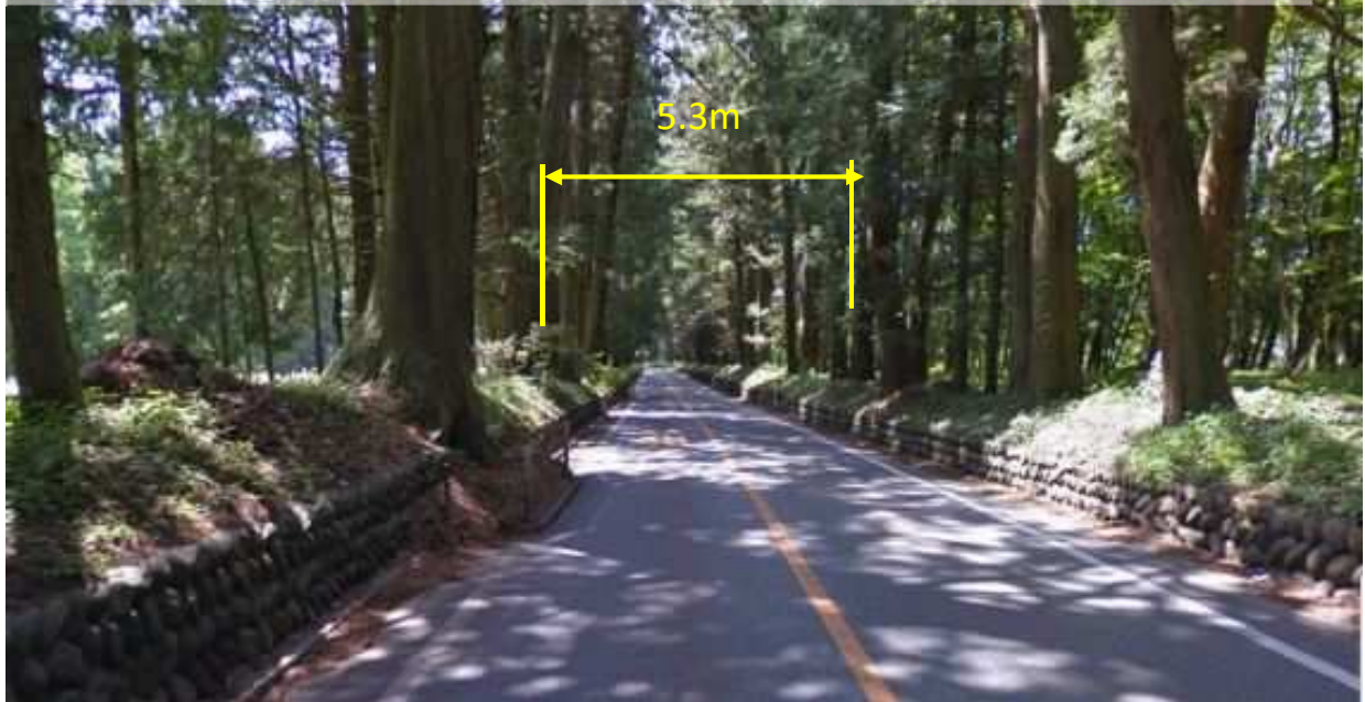
①幅員狭小で歩道が未整備
