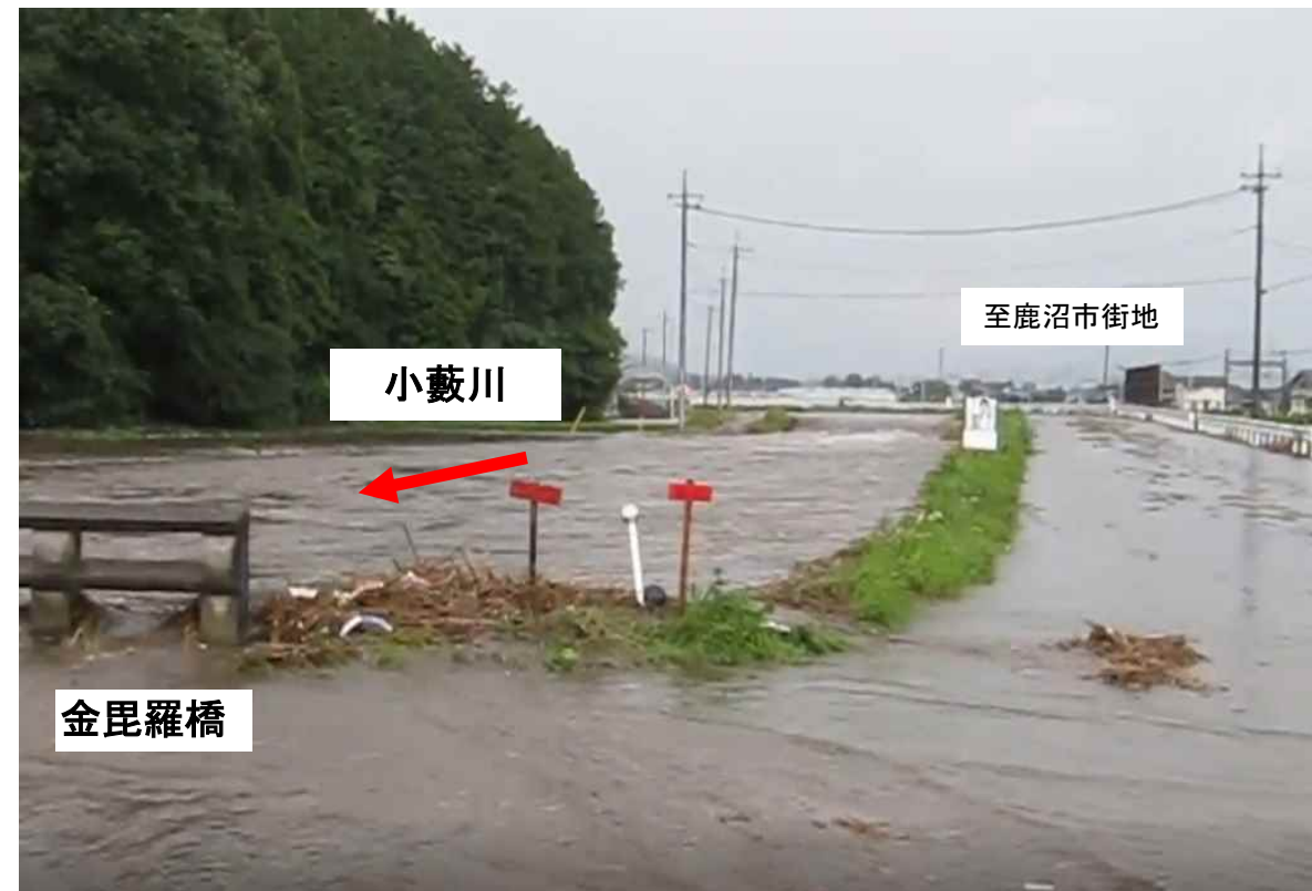
平成25年7月27日撮影 金毘羅橋上流
