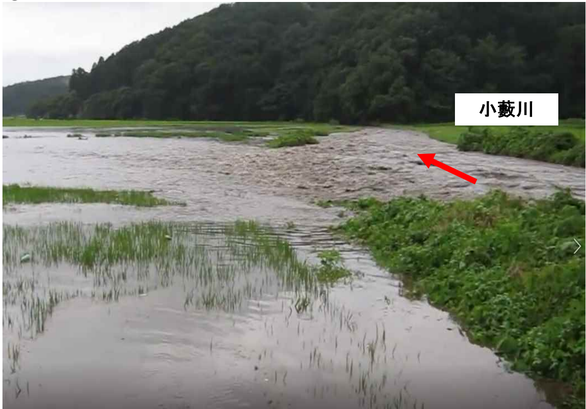
平成25年7月27日撮影 金毘羅橋下流
