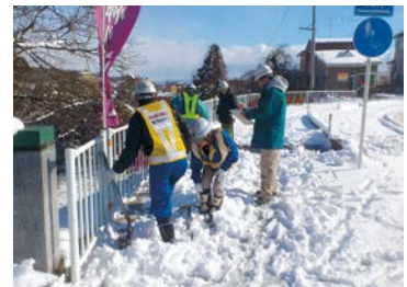
雪の中の完成検査
