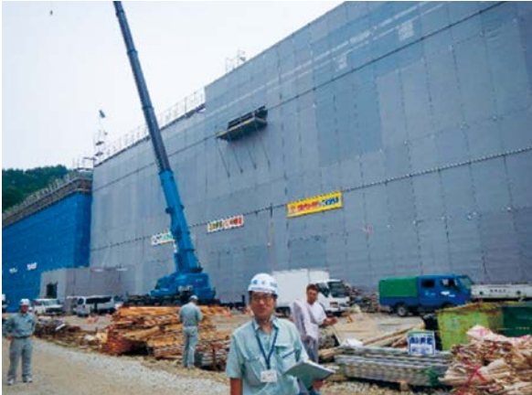
釜石市平田地区（工事監督状況）
