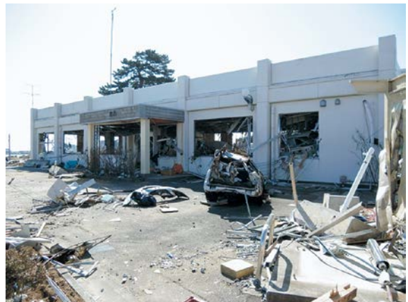
(被災した相馬港湾建設事務所)
