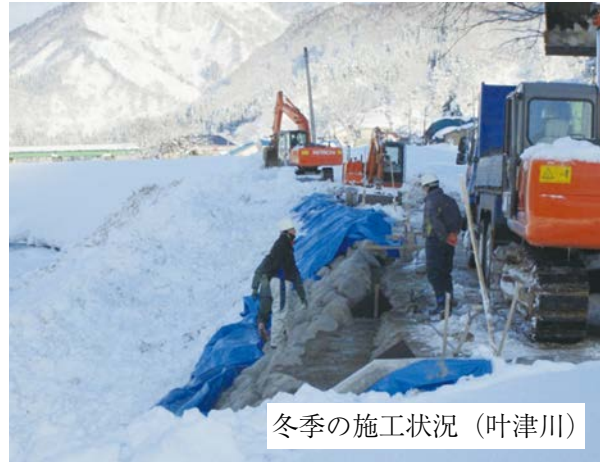
冬季の施工状況（叶津川）
