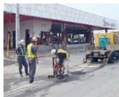
査定申請工法の根拠としての舗装版のコア採取
