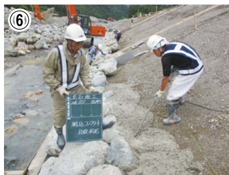
胴込コンクリート打設、バイブレーター施工
