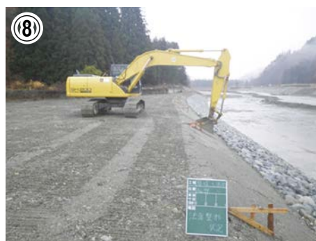
法面整形後、張芝工を実施して完成
