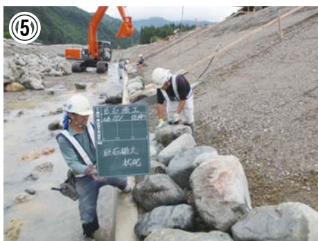
石の据付け（2～3段程度）
