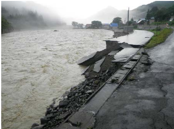
河川氾濫（叶津川）
