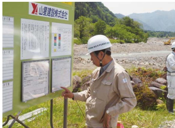
任期付職員の高萩氏 元施工業者のため現場管理には間違いが無かった。
