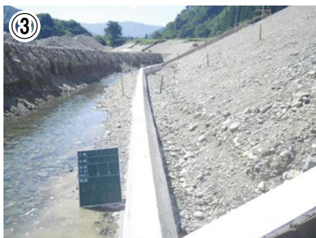
基礎コンクリート工
