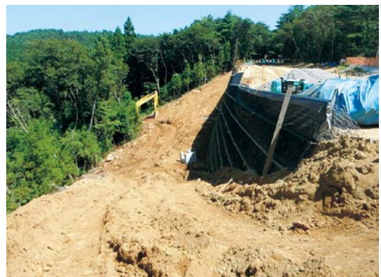
補強土壁工事状況
