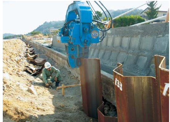
海岸堤防復旧工事状況
