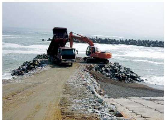
仮設道路設置状況
