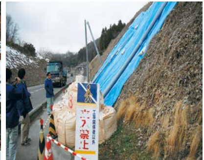
法面崩落箇所の現地調査
