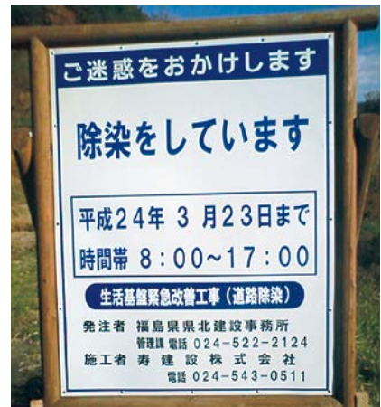
除染工事の看板
