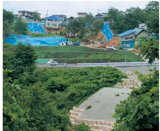
国道4号の斜面崩壊箇所
