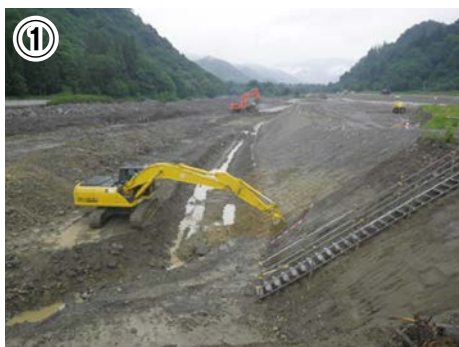
掘削工、法面整形工
