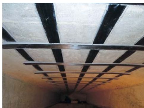
対策後（橋桁等の補修）
