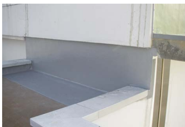
復旧：CB積み、塗膜防水により改修
