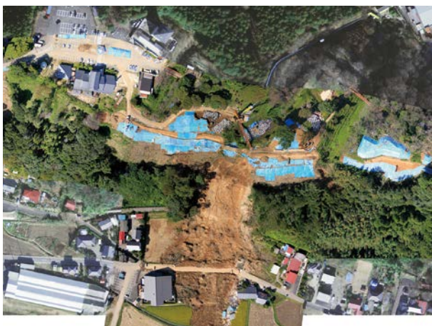
斜面崩壊発生状況
