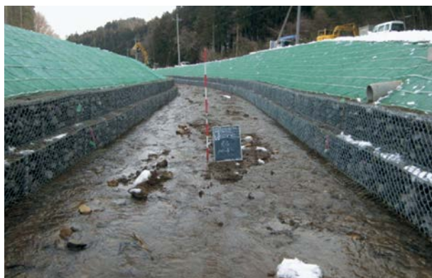
工事完了写真
