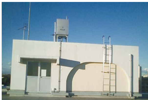
復旧：塔屋上部の壁撤去
