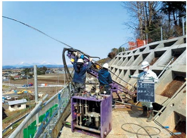
鉄筋挿入工
