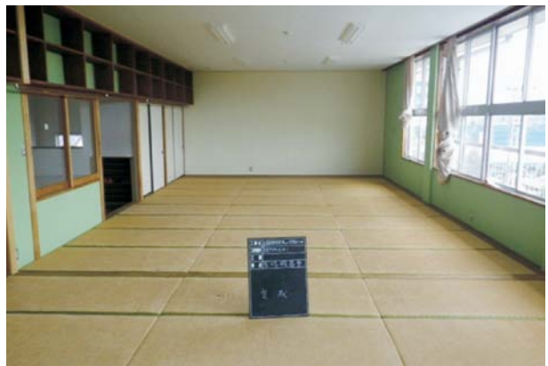
復旧：下地補強及び内装改修
