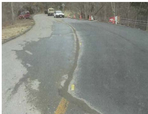
日塩有料道路（もみじライン）カーブ16 (舗装打替え工 作業後)
