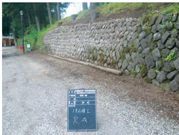
石積み完成状況
