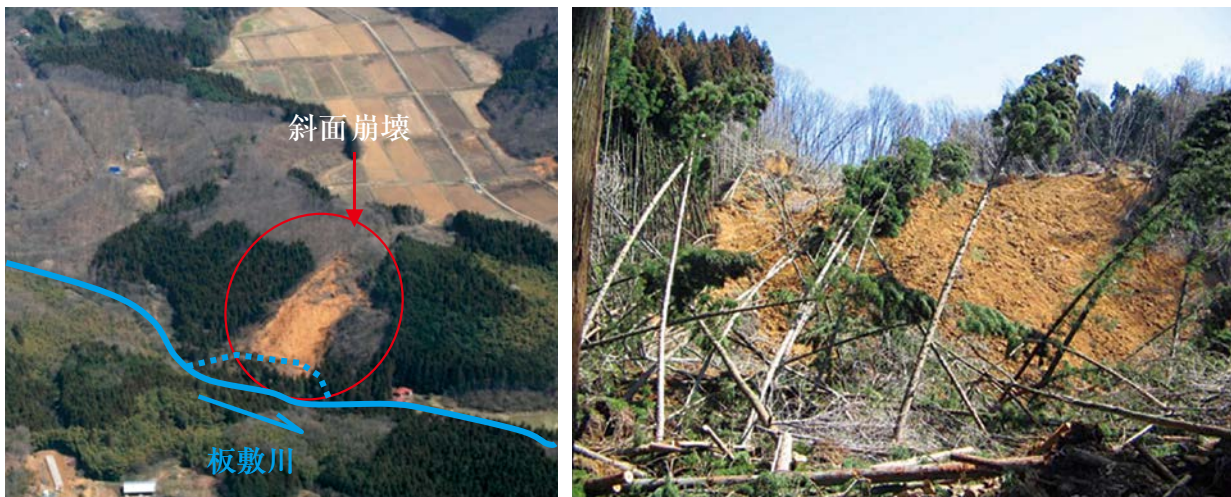
斜面崩壊状況
