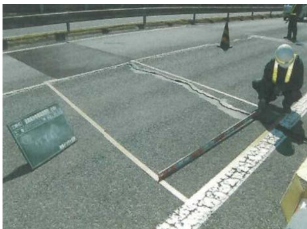
日光宇都宮道路上り14.86KP (段差すり付け工 作業前)
