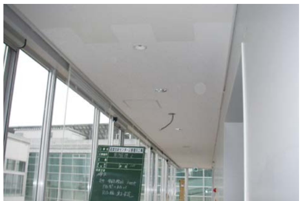
復旧：天井下地、ボード復旧
