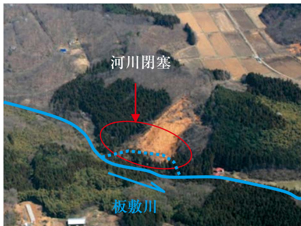
被災状況（航空写真）
