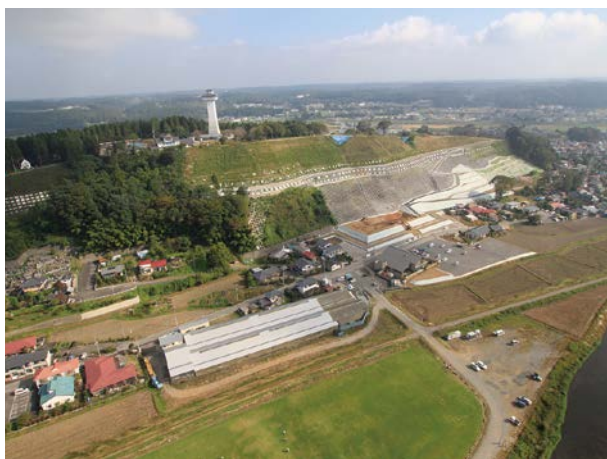
施工状況全景
