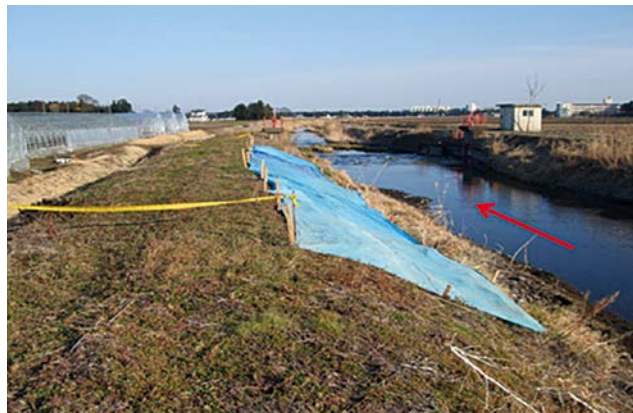
ブルーシートによる応急対策状況
