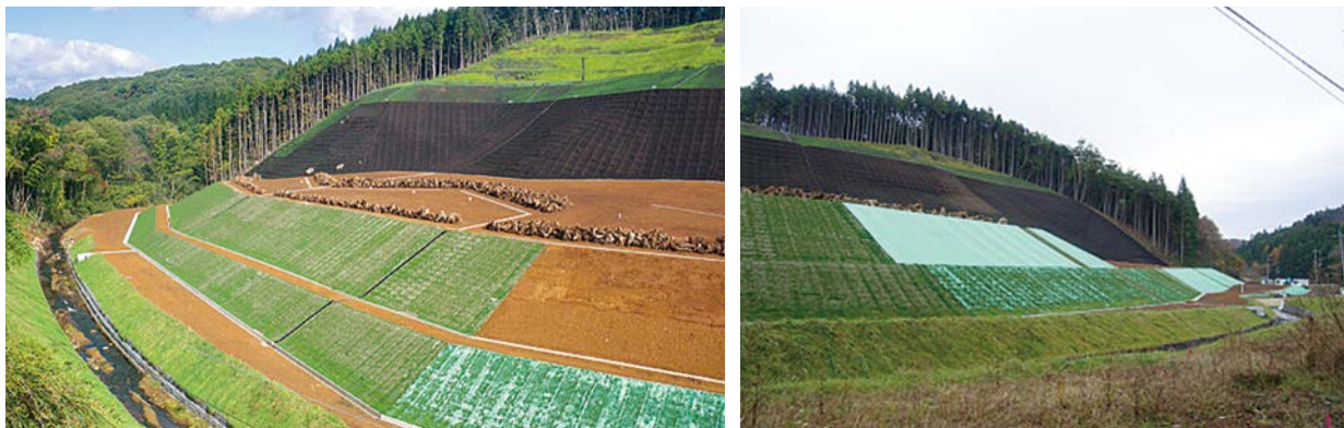
復旧対策全景
