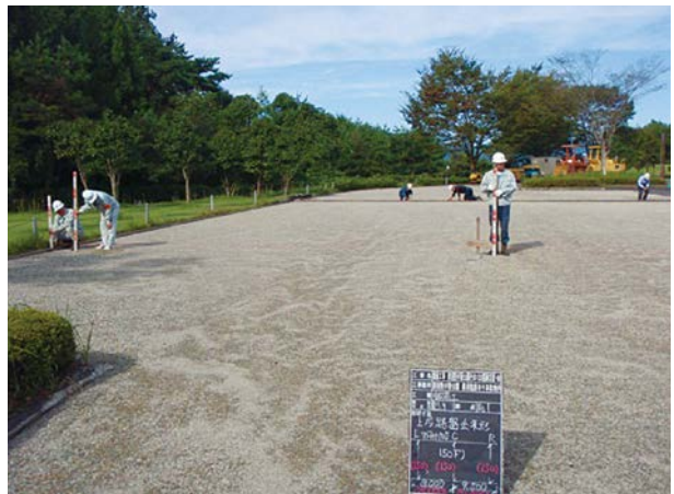
路盤完成状況
