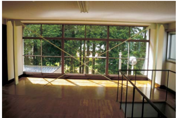
復旧：耐震補強（耐震ブレース新設）
