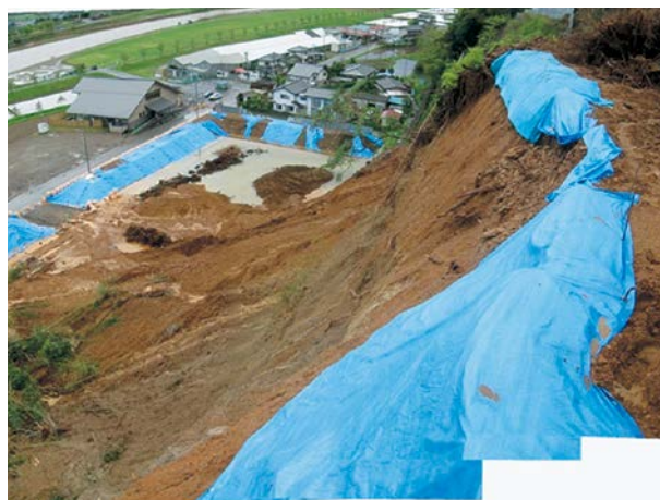
斜面上部より崩壊状況
