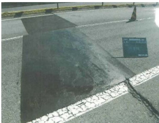
日光宇都宮道路上り14.86KP (段差すり付け工 作業後)
