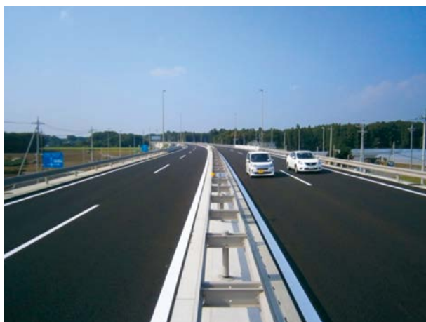
真岡宇都宮バイパス (平成25年12月21日全線開通)
