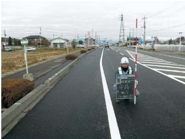
路面仮復旧状況
