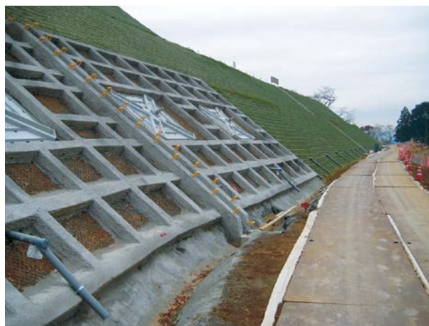
法枠工、アンカー工
