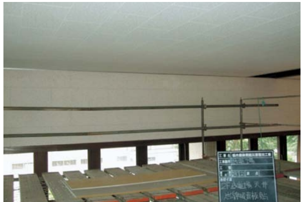
復旧：天井材の張替
