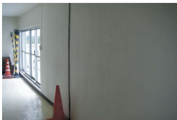
復旧：クリアランスを確保し、壁躯体改修
