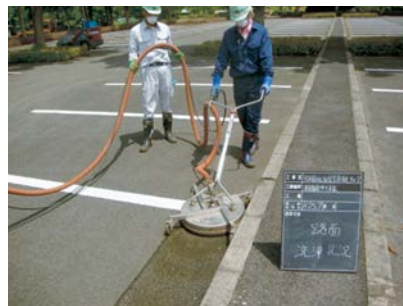
路面洗浄状況
