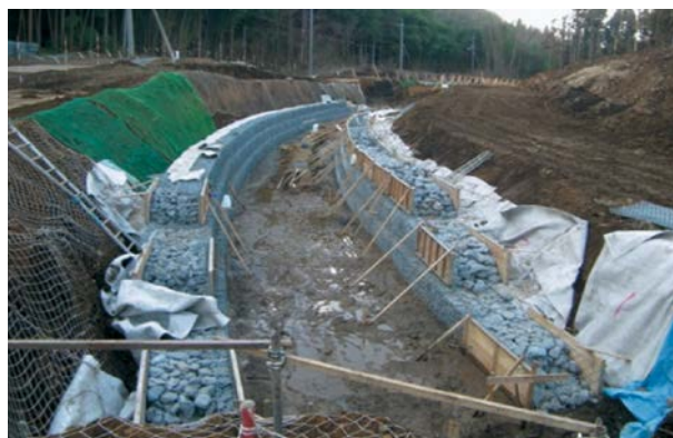
付替え河道の施工状況
