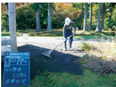
目土散布（人力）
