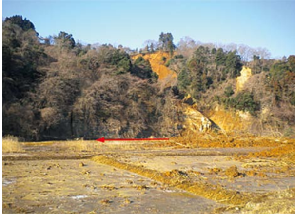
山腹崩壊状況
