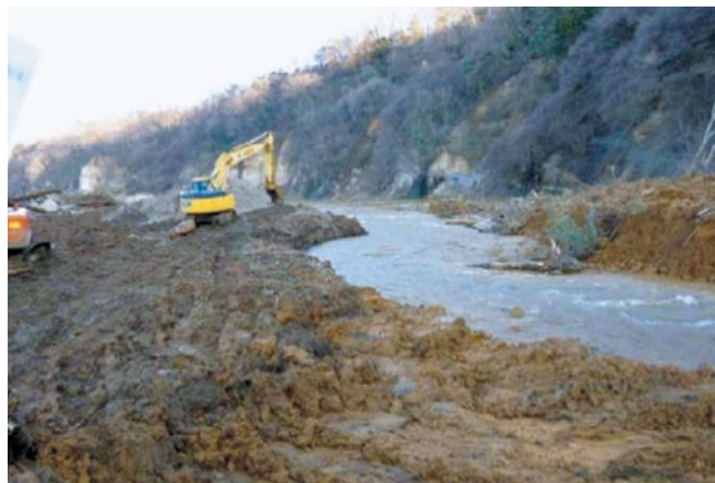
応急工事実施状況
