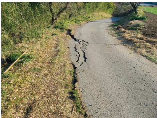
台地上に発生した亀裂
