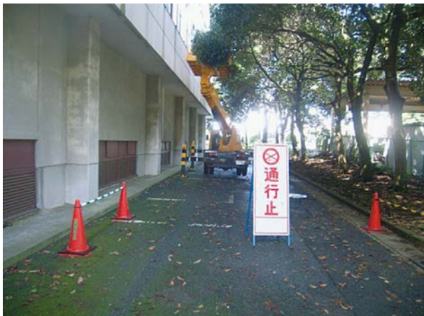
高所作業車による交換
