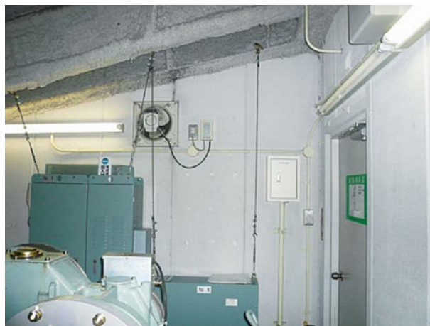
エレベーター室機器の復旧状況
