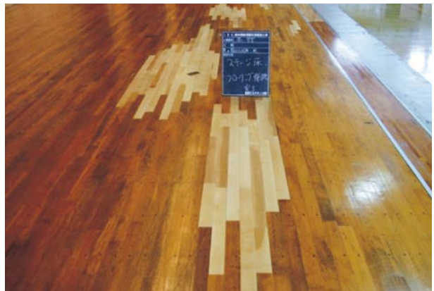
復旧：フローリング板の張替
