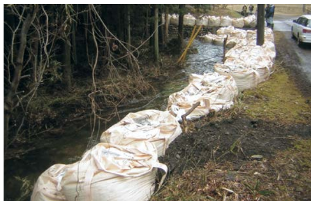
応急工事实施状況
