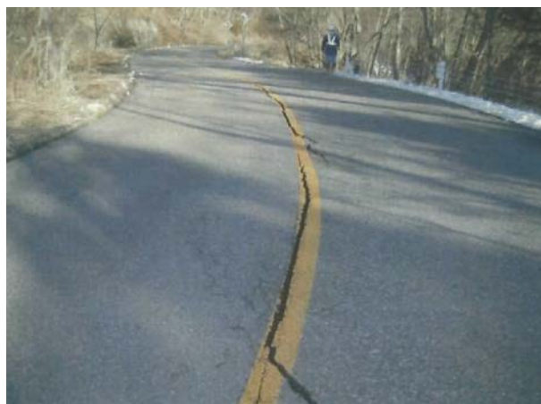
日塩有料道路（もみじライン）カーブ16 (舗装打替え工 作業前)
