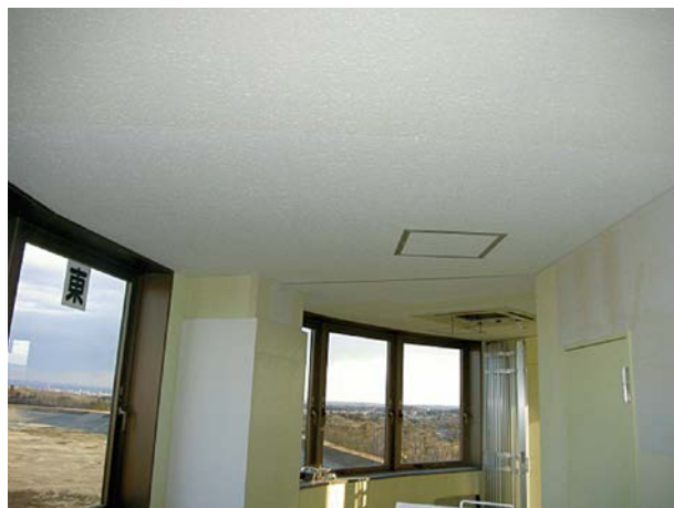
空調器及び天井復旧状況
