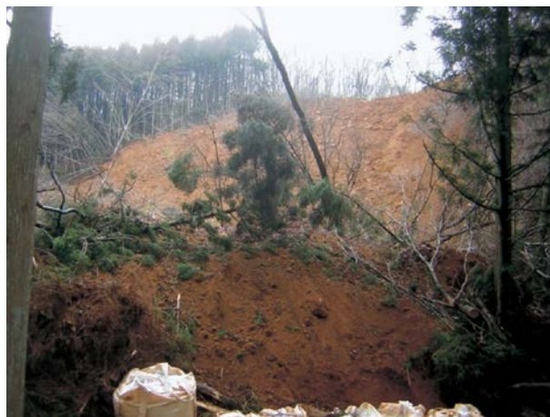
山腹崩壊状況
