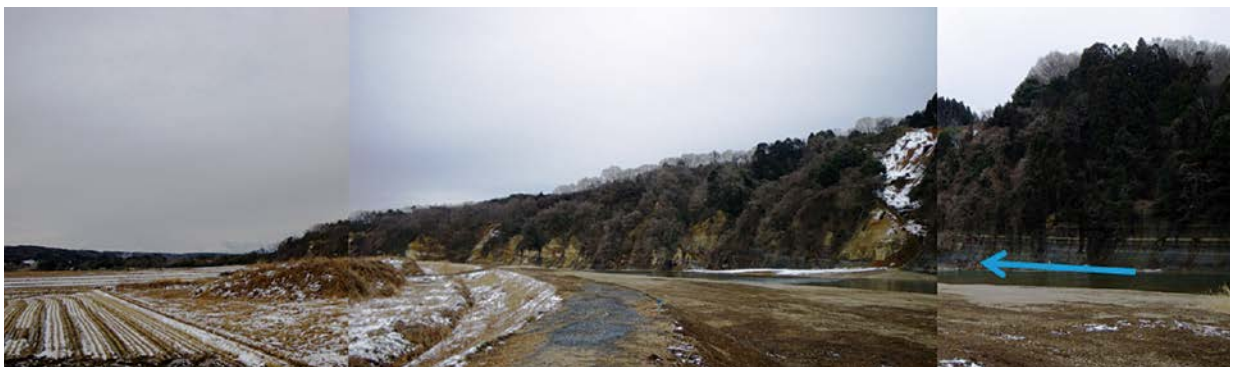
工事完了写真
