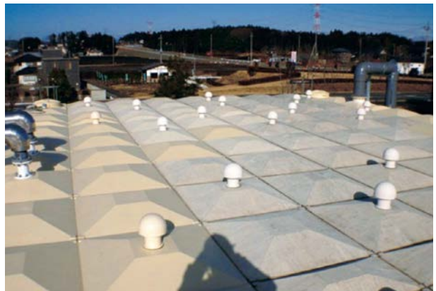
復旧：受水槽パネル張替
