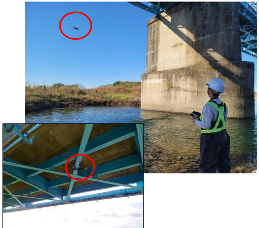
ドローンによる高所点検
